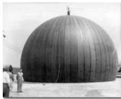
Rysunek 6.20: Kopuła Birdair z podłużnych pasów (birdair.com)
