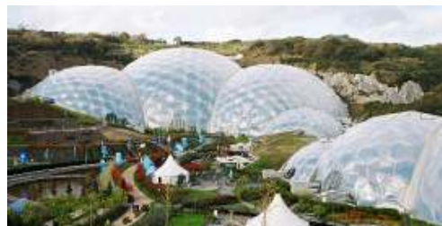
Rysunek 6.17: Projekt Eden: metalowa konstrukcja z pneumatycznymi panelami (Eden Project Ltd.)
