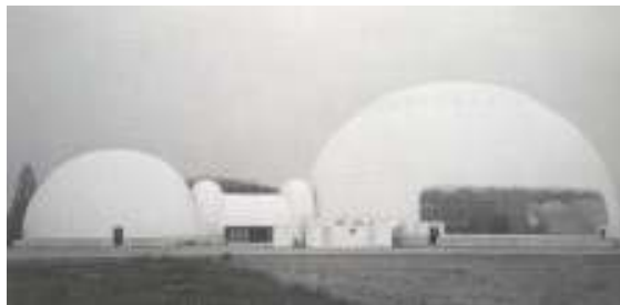
Rysunek 6.12: Pneumatyczny pawilon ZDF, Mediadrom, średnica dużej kopuły: 51 m (Schock 1997)
