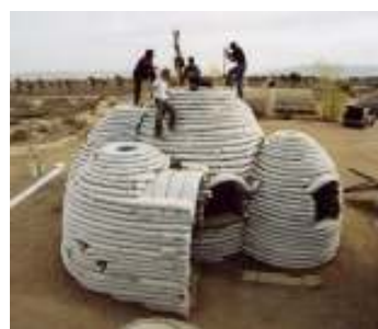
Rysunek 6.56: Gotowa konstrukcja z Super Adobe (Cal-Earth)
