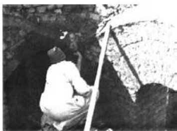
Rysunek 6.52: Wyznaczanie foremnej kopuły przy pomocy kija (Petrov 2004)
