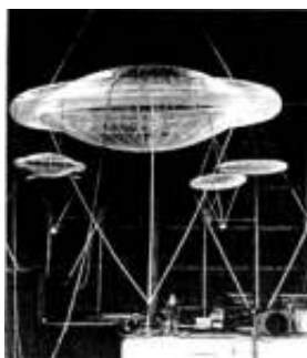
Rysunek 6.19: Soczewkowy Reflektor Paraboliczny Goodyear (Freeland i in. 1998)
