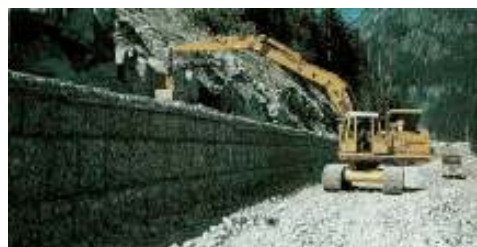
Rysunek 6.42: Koparka ładująca gabiony (BMTG)
