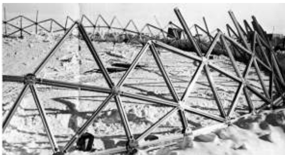
Rysunek 5.4: Konstrukcja kopuły w czasie budowy (southpolestation.com)
