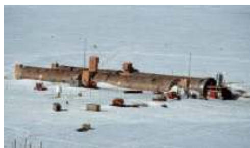
Rysunek 5.6: Widok na stację Halley IV z metalowych rur przed zasypaniem śniegiem (British Antarctic Survey)
