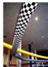
Rysunek 6.75: Pneumatyczny dukt instalacyjny AirDuct (AirDD)
