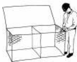
Rysunek 6.41: Robotnik montujący gabion (BMTG)
