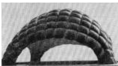
Rysunek 6.14: Wielokomorowe przekrycie pneumatyczne (typ II) (Tarczewski)
