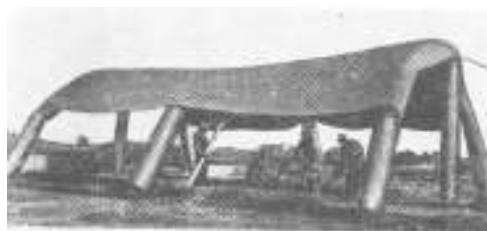
Rysunek 6.15: Magazyn o konstrukcji żebrowej (typ III) (Tarczewski)
