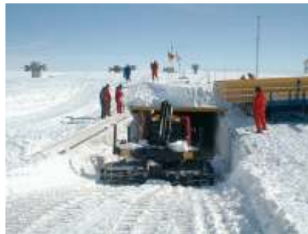
Rysunek 5.13: Wjazd do podlodowego garażu na stacji Neumayer (Alfred Weneger Institut)
