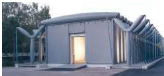
Rysunek 6.16: Pneumatyczny pawilon wystawowy Festo z nadmuchiwanymi belkowymi i słupowymi elementami wsporczymi
