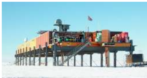
Rysunek 5.8: Budynki kontenerowe na rusztowaniu z platformą (stacja Halley V) (British Antarctic Survey)
