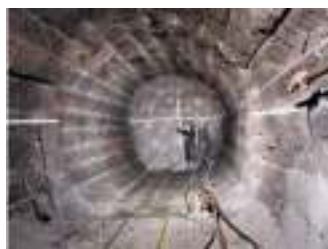
Rysunek 6.34: Warstwa urobku po rozsadzeniu długimi otworami (laboratorium w Winnipeg) (Kuczyk 2002)
