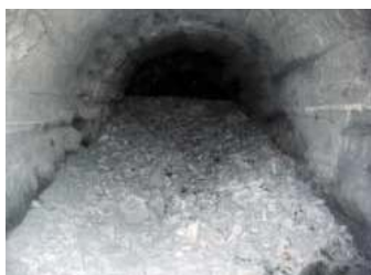
Rysunek 6.33: Wnętrze wyrobiska o gładkich ścianach, podziemne (laboratorium w Winnipeg) (Kuczyk 2002)
