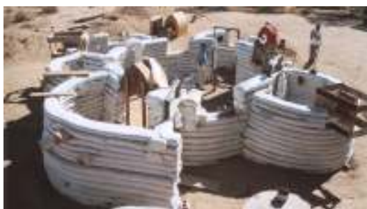
Rysunek 6.55: Konstrukcja z Super Adobe w czasie wznoszenia (Cal-Earth)
