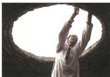
Rysunek 6.53: Murowanie kopuły bez rusztowania (Petrov 2004)
